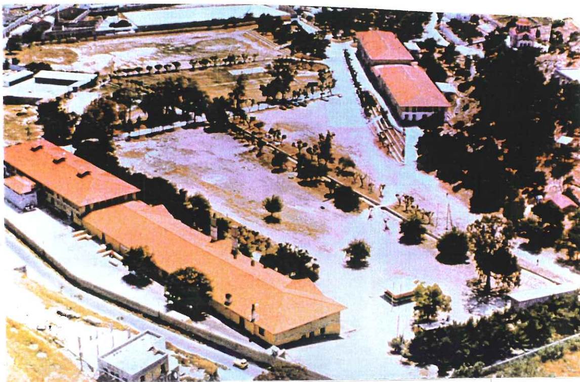
ΣΥΡΟΣ: Άποψη των κτιριακών εγκαταστάσεων της ΣΜΥ
